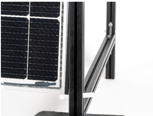
Abbildung 14: Falsches Einsetzen des Moduls
